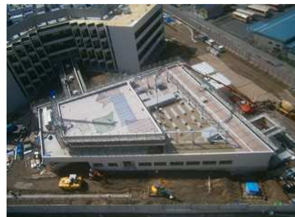
躯体工事が完了し内部の工事に進捗しています
