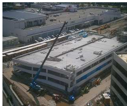
建屋北東上部より
