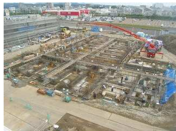
基礎工事施工中です
