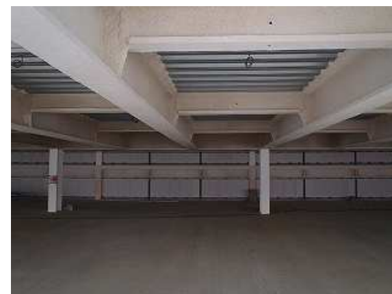
内部施工状況
