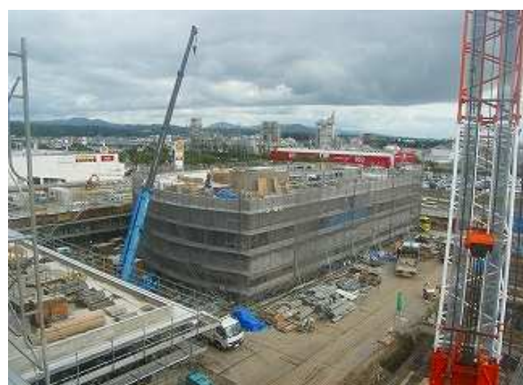
躯体工事がほぼ完了します
