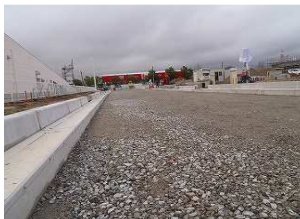
道路新設状況
